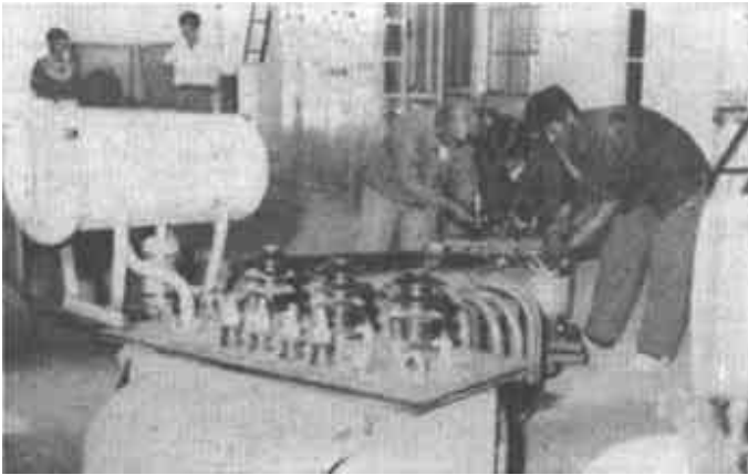
为更新改造高耗能变压器，全市设立了7处改造点。图为广饶电业局正在改造设备。（丽英 摄）
